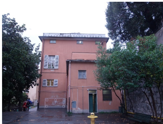
Figura 1.1 - Vista della facciata esposta a Sud-Est
