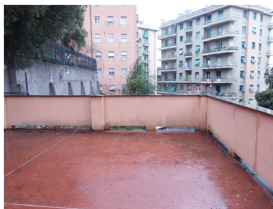
Figura 8.1 - Particolare della copertura / terrazzo
