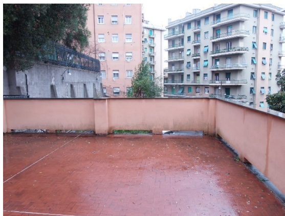
Figura 8.3 - Particolare della copertura / terrazzo
