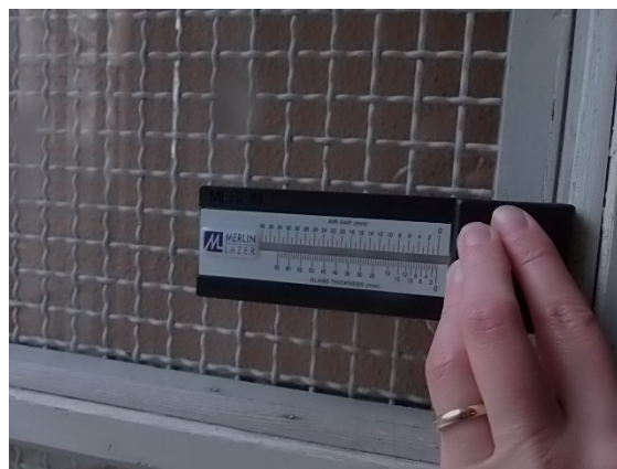
Figura 4.4 - Particolare dei serramenti
