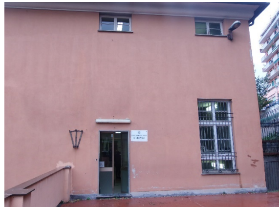
Figura 4.1 - Particolare della porzione di involucro del piano primo esposto a Sud-Est.
